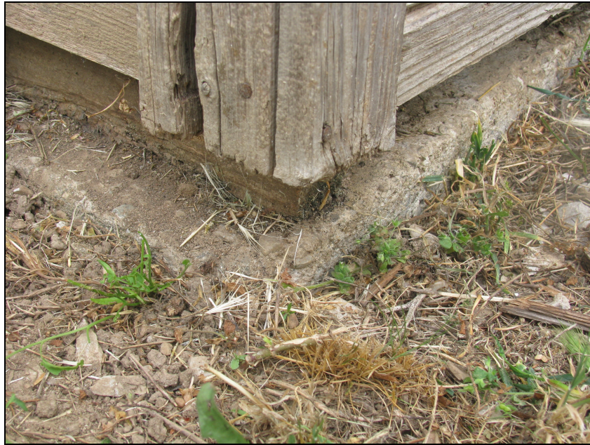
Particolare massetto in cls
