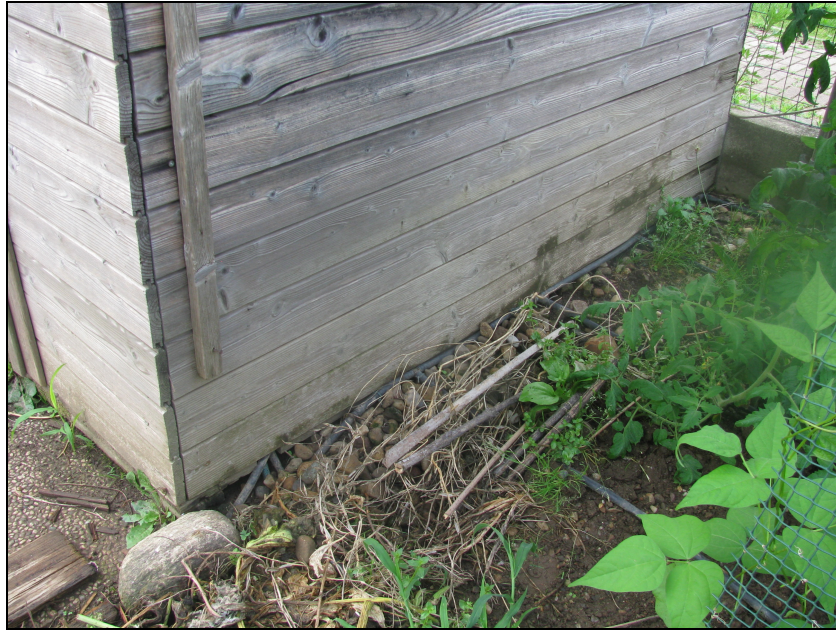
Lato basamento a contatto con la terra
