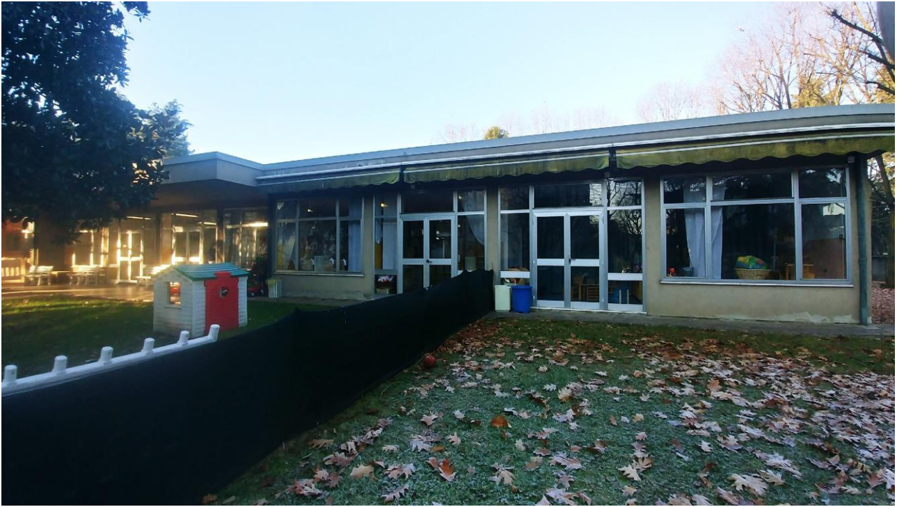
FOTO 1. VISTA FRONTE SUD
