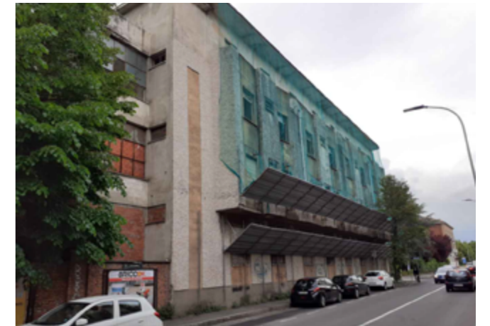
02- vista edificio in corso di demolizione lungo viale Circonvallazione
