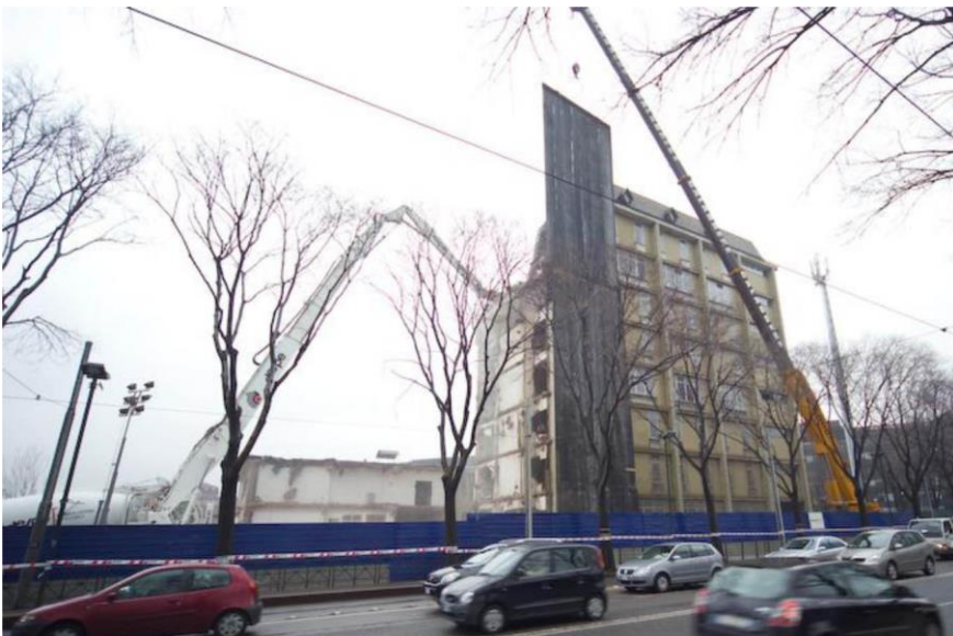
Illustrazione fotografica di demolizione con metodo analogo a quello in progetto
