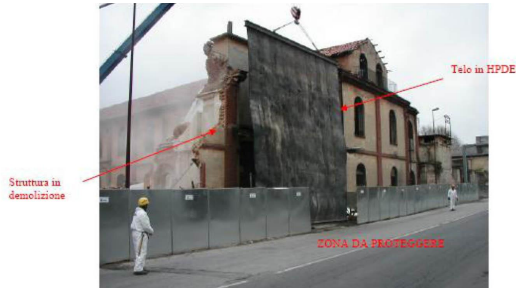
Immagine riportante l'utilizzo di teli protettivi in HDPE
