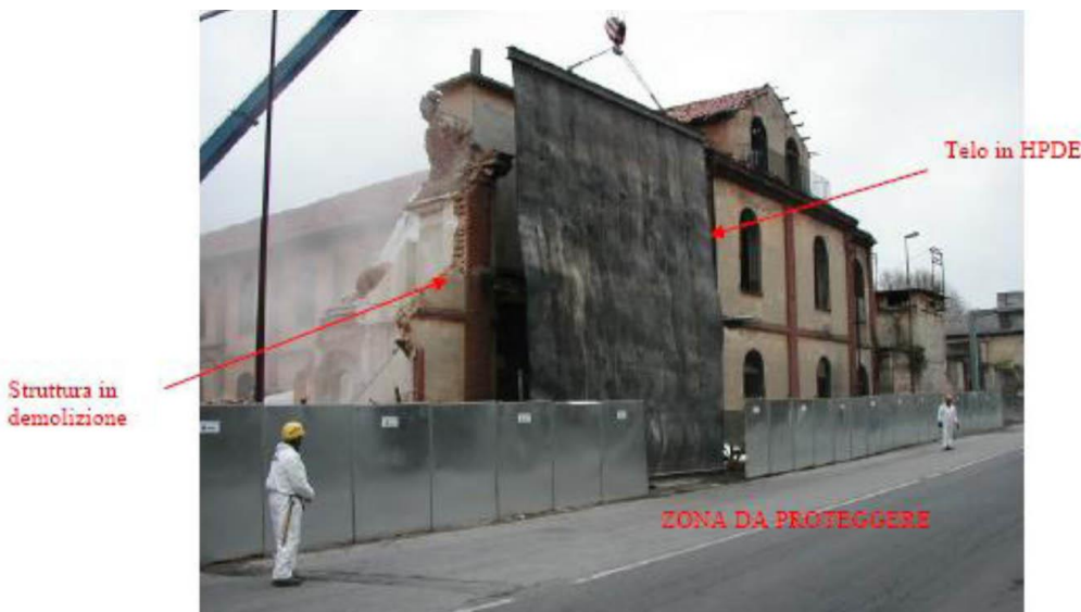
Immagine riportante l'utilizzo di teli protettivi in HDPE
